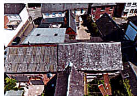
Crèvecœur-le-Grand « ancien collège » CA du Beauvaisis Diagnostics écologiques, déchets et immobiliers avant déconstruction
